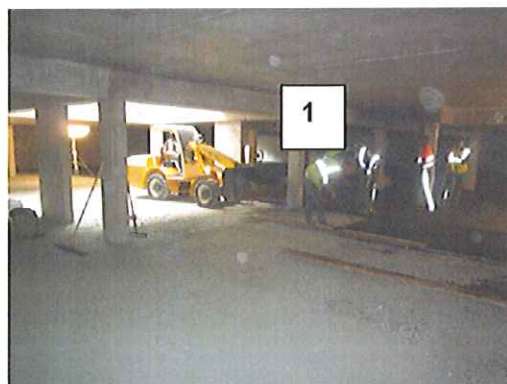
Dépose du bitume
